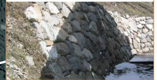
Endiguement léger de l'exutoire
